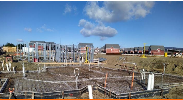
Uso de Moldajes Metálicos
