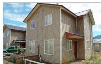
PIÑERAS.— Las 70 viviendas del conjunto "18 de noviembre", de Coyhaique, tienen un sistema de aislamiento térmico con lana de vidrio en los muros,
