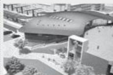
Línea ferroviaria que conectará este y oeste de Londres
