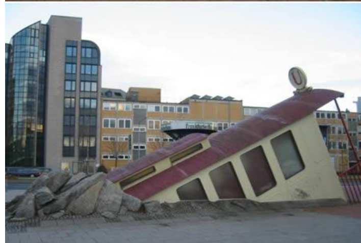
Estación de Metro Bockenheimer, en Frankfurt
