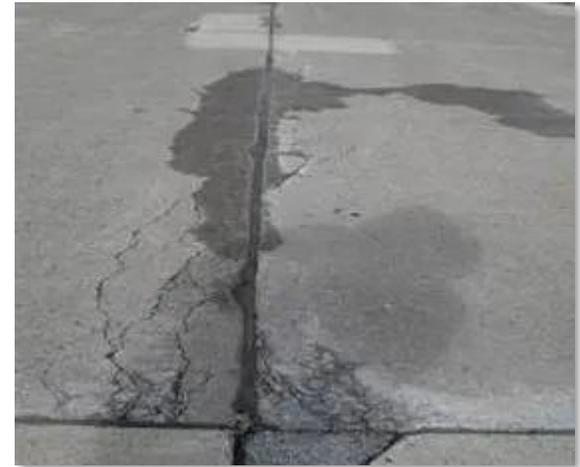
Superficie del Hormigón sometido a Hielo/Deshielo
