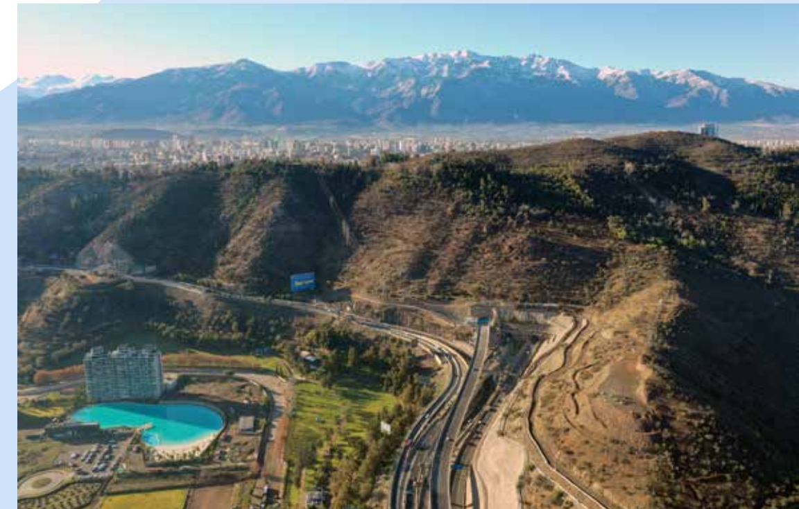
Sector viaducto y la Pirámide, Región Metropolitana (AVO).
