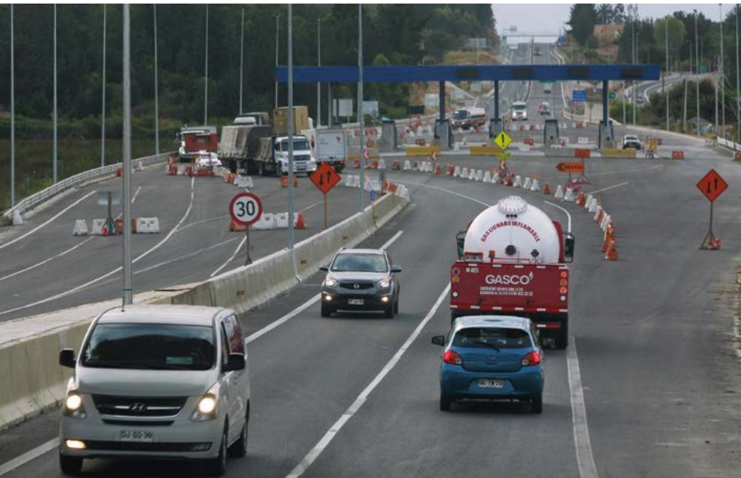
El mejoramiento de la ruta a Cabrero es un proyecto primordial para el MOP.
