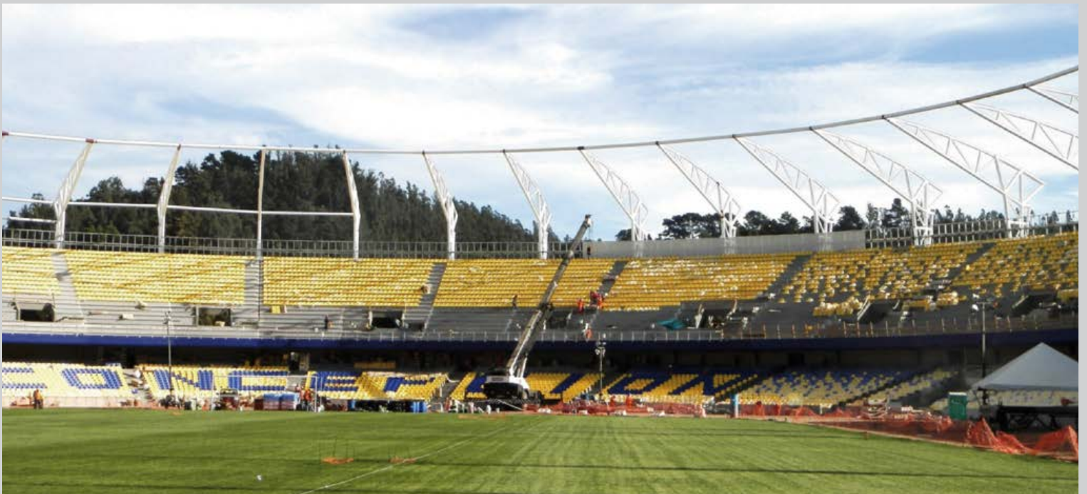
Obra MOP: Remodelación Estadio Ester Roa Rebolledo, Concepción. (Abril 2015).
