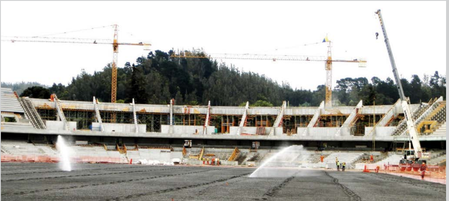
Obra MOP: Remodelación Estadio Ester Roa Rebolledo, Concepción. (Diciembre 2014). Empresa Constructora Claro Vicuña Valenzuela s.a.
