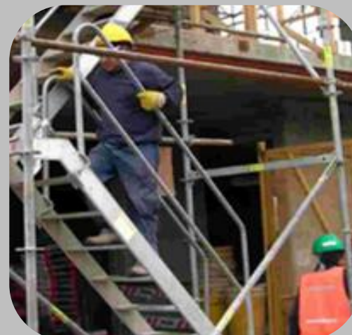
USO DE ANDAMIOS CON ESCALERAS INTERIORES
