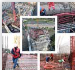
Postensado Losas y Vigas, Pilares
