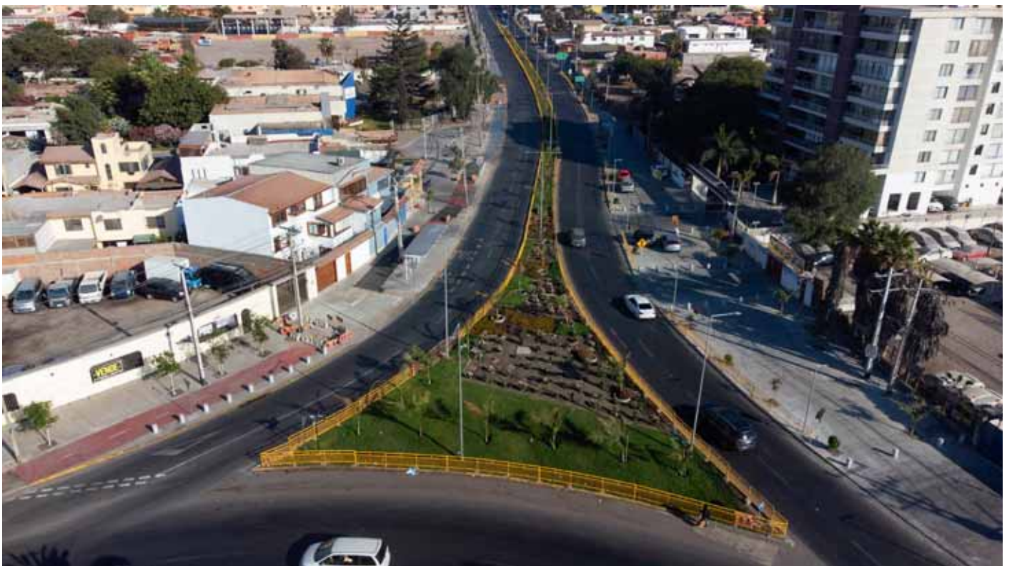
Trabajos en la entrada de Azapa, 2023. Fotógrafo Patricio Banda.
