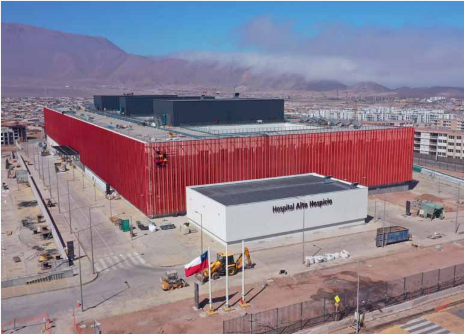
Uno de los desafíos es acelerar los tiempos de ejecución de proyectos de infraestructura como los hospitales.
